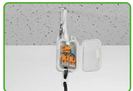
Anschluss von Pendelleuchten in abgehängten Decken
