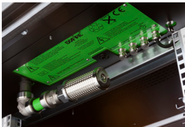
MiniCube 3,5 kW – Advanced opstelling met ExxFire brandblussysteem
